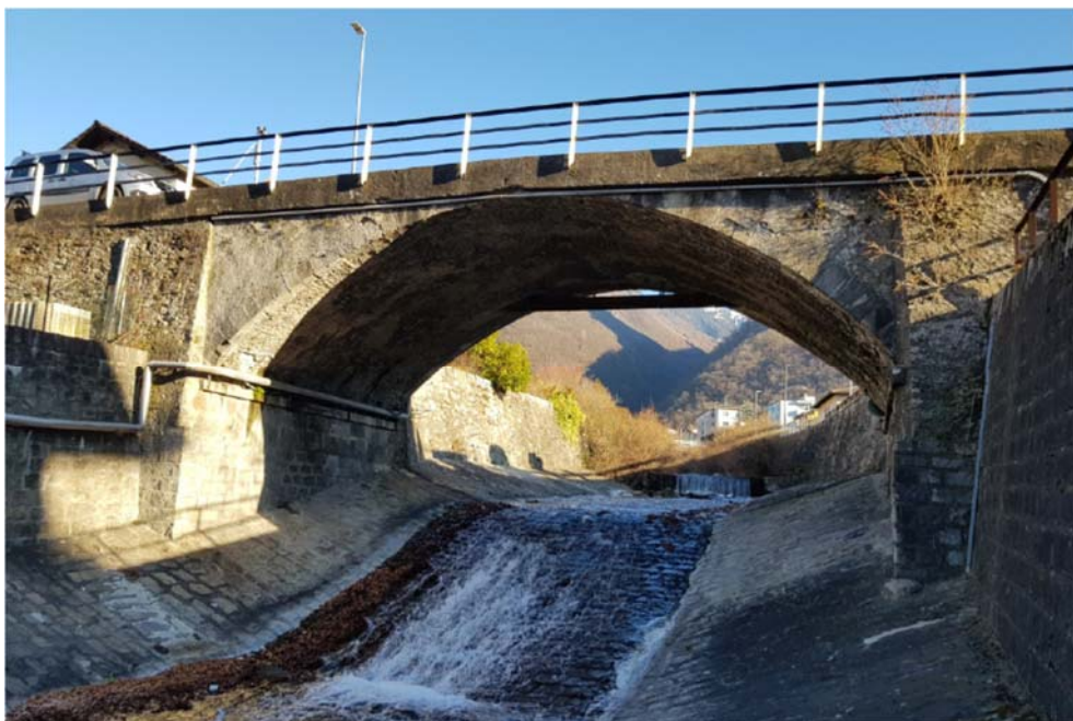
Ponte visto da Ovest
