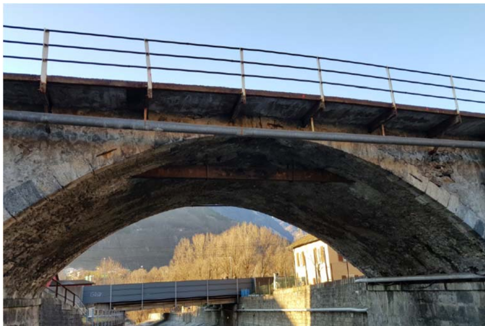
Ponte visto da Est Aggiunta del marciapiede in cemento armato, infrastrutture tecniche
