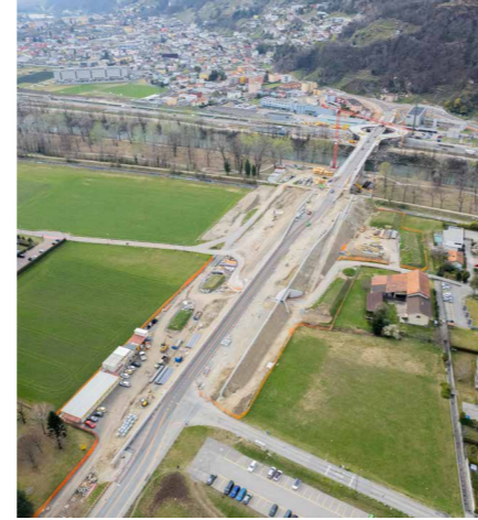
2022-2023: adeguamento di Via El Stradùn e allargamento di Via Tatti.
