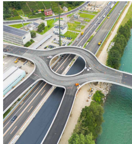
Giugno 2024: completamento del nuovo ponte.
