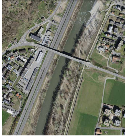
Marzo 2022: stato prima dell'inizio dei lavori.
