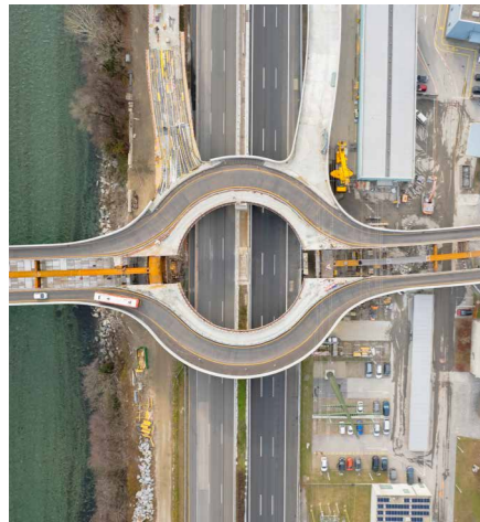
2023: demolizione del vecchio ponte e realizzazione delle rampe.
