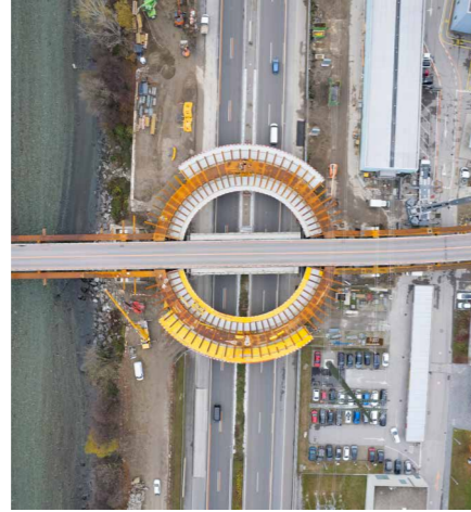
2022: dopo la demolizione delle mensole esterne del vecchio ponte, si è proceduto alla posa della carpenteria metallica per il nuovo ponte e per la rotonda del Semisvincolo.
